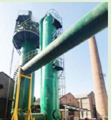
梭式窑、烟气脱硫脱硝系统、湿电除尘系统项目
