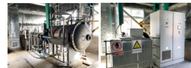
图 2 臭氧脱硝系统改造现场图片
